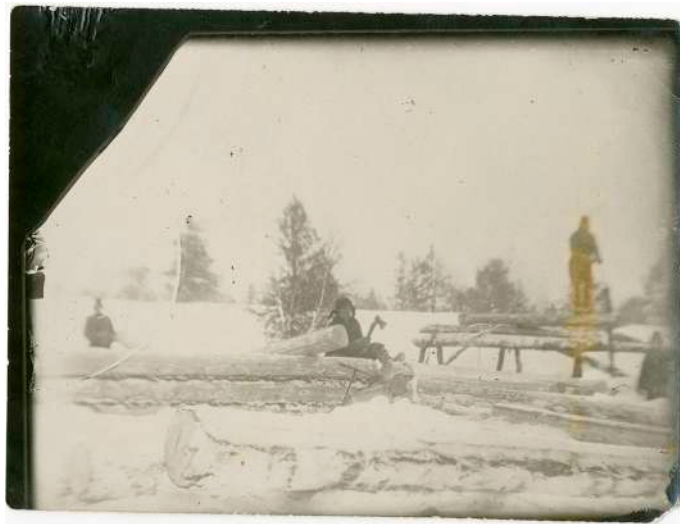
Строительство нового деревянного здания Толькинского Красного чума. пос. Толька. 1934 г. НКМ
